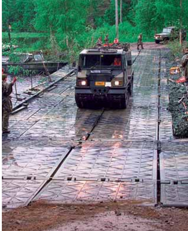
Pontonbro i användning. Bron är byggd av pionjärer.
